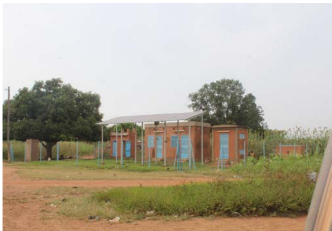
Site du forage et local technique AEPS de Saponé
