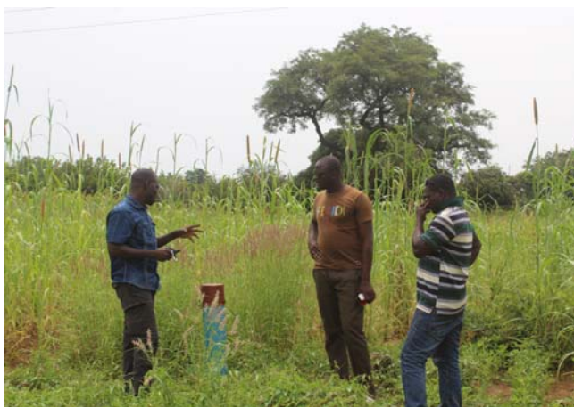
Vue partielle site du forage à Rakaye (Doulougou)
