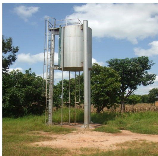
Photo 14 ; Château d'eau d'une Adduction d'Eau Potable Simplifié à To
